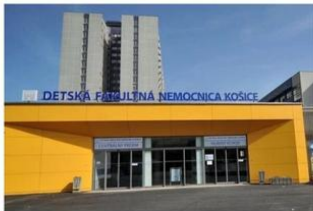
Detská fakultná nemocnica v Košiciach dlhé roky pôsobila v univerzitnej nemocnici v jernsiarých priestoroch. V postadi je monoblok, kde taktied ležali detskí pacienti roztriesení na viacerých poschodiach. (Zdroj: Korzář/Ľubita Černáková)
