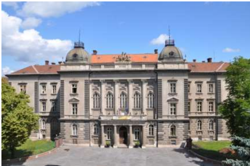
Budova rektorátu UPJŠ v Košiciach na Šrobárovej č. 2
