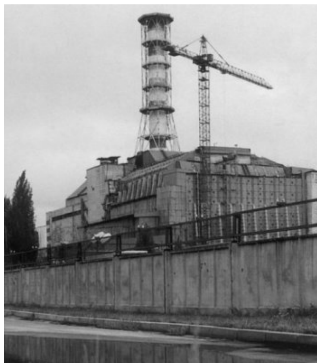
Obr. 43 Betónový kryt havarovaného reaktora, tzv. sarkofág.
