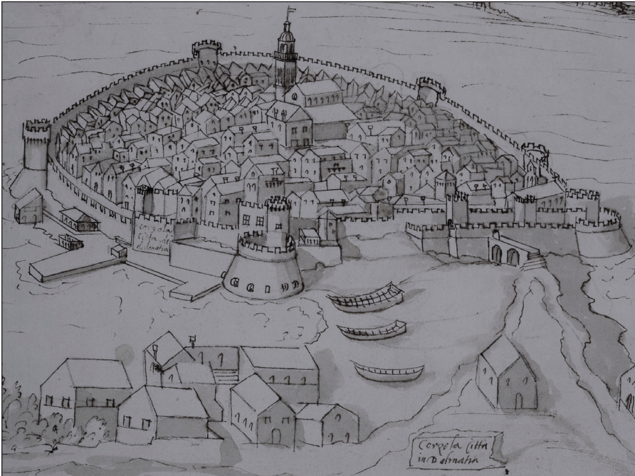
Figure 5: Korčula. In: Archivio di Stato di Torino, Biblioteca Antica, Architettura militare, disegni di piazze e fortificazioni, parte su pergamena, Vol. V, Pianta della città. Curzola. f. 96 (detail).
