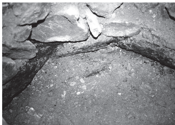
Obr. 6 – Studňa na Hlavnej ulici, pri Immaculate. Pohľad na styk kamennej a drevenej základovej konštrukcie.
