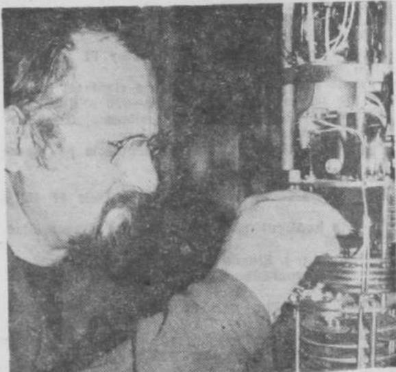
Technik Katedry experimentálnej fyziky Pf Norbert Smolka pri montáži vodičov do vnútra refrigerátora.
