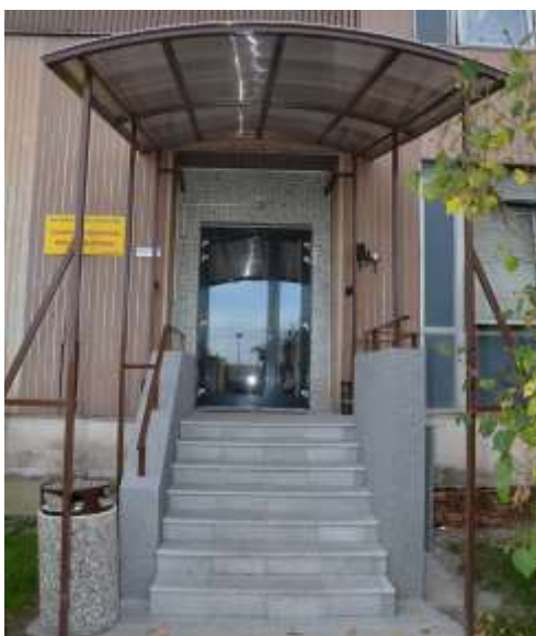
Zrekonštruovaný zadný vchod do budovy LF UPJŠ v Košiciach
