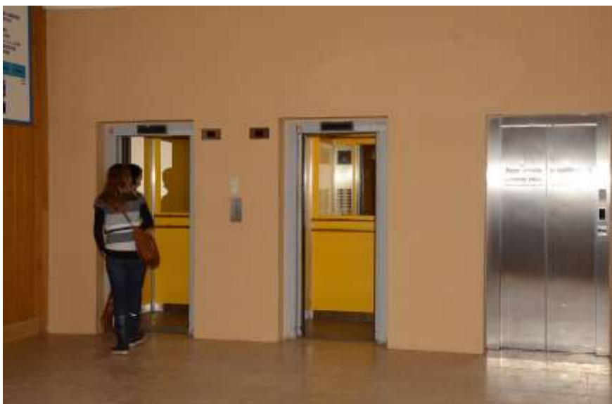
Opravené výtahy so zrekonštruovanými kabínami vo vestibule budovy dekanátu LF UPJŠ v Košiciach
