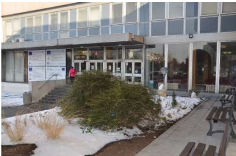
Zrekonštruované schodisko a nové lavičky pri hlavnom vchode do budovy LF UPJŠ
