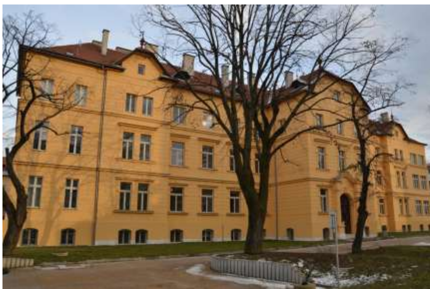
Zrekonštruovaná Budova Aristoteles Filozofickej f. na Moyzesovej 9
