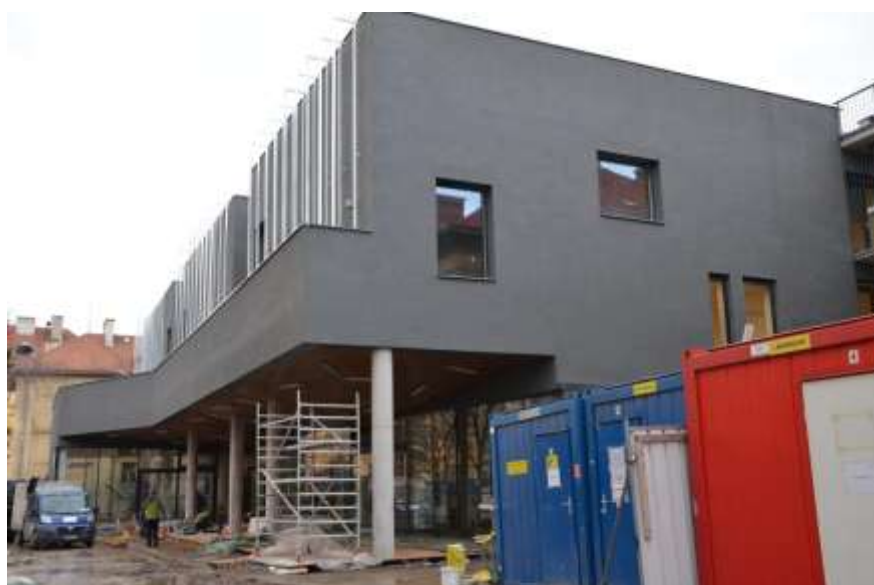
Prebiehajúca rekonštrukcia na Pavilóne „F“ na Moyzesovej 9
